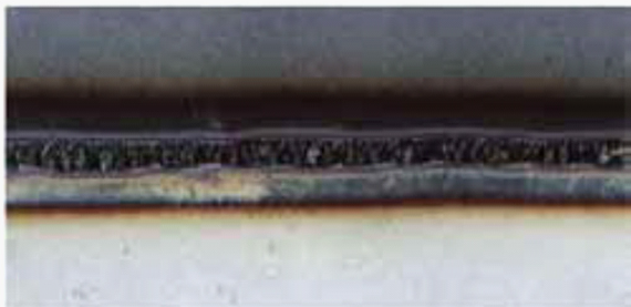
Schweißnaht ohne Wurzelschutz
