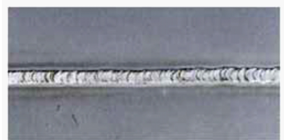
Schweißnaht mit Wurzelschutz
